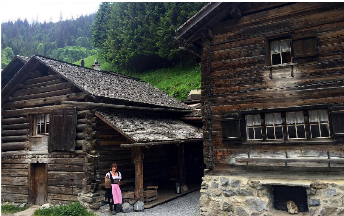
Bild: Links von vorher gezeigtem Häuschen weitere historische Häuser, rechts das Mesmerhaus von 1588.
