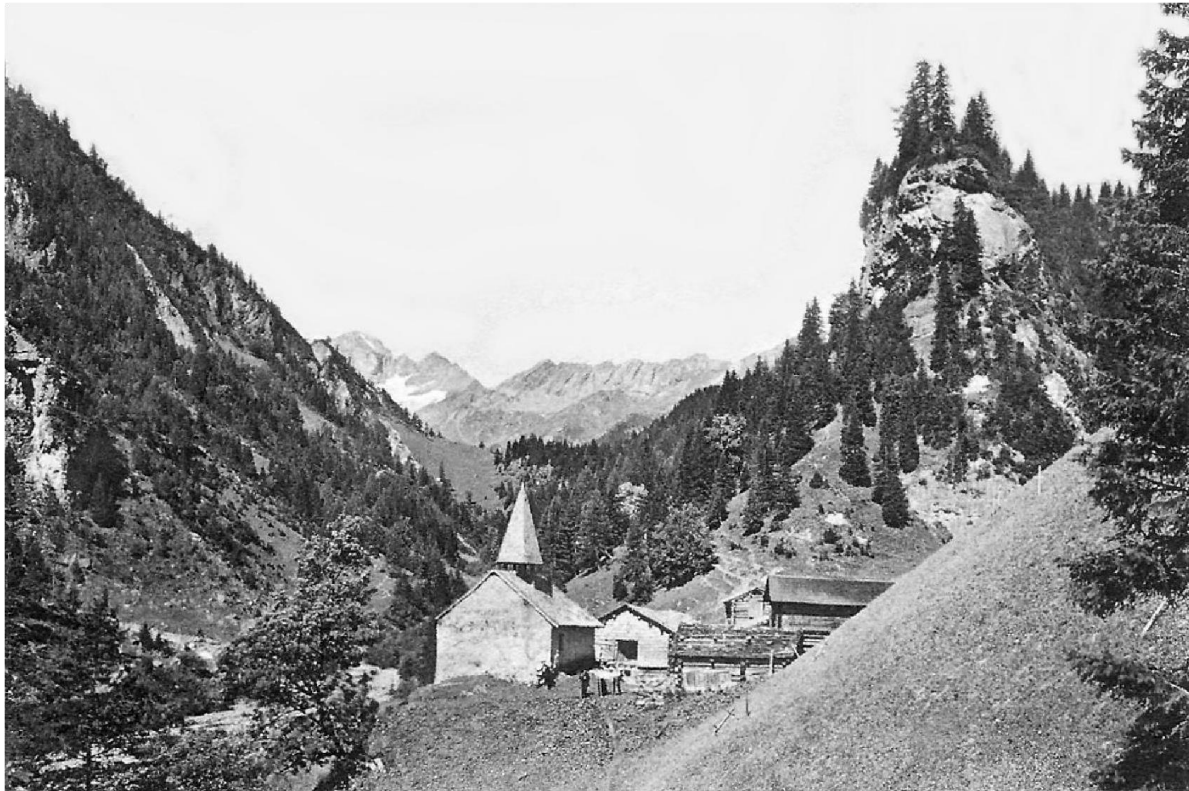
Bild: Ein Schutzkreuz über dem Kirchenplatz etwa am selben Ort ist schon auf einer alten Ansicht zu erkennen (1940er Jahre oder früher).
