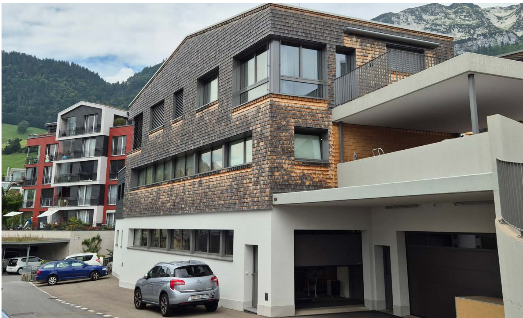
Der Ammler Schindelmacher Robert Thoma vor seiner 50-jährigen Schindelfassade (oben links), Rolf Steinbacher nagelt Fichte-Schindeln über Lärchenteil (oben rechts) und Schindelfassade am Neubau von Richard Bolt in Amden.
